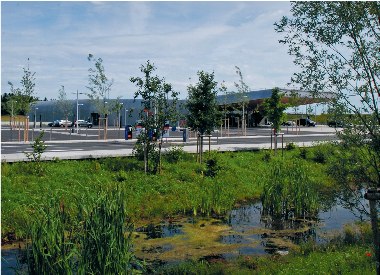
Bassin de rétention de la gare de Belfort-Montbéliard TGV. AREP
