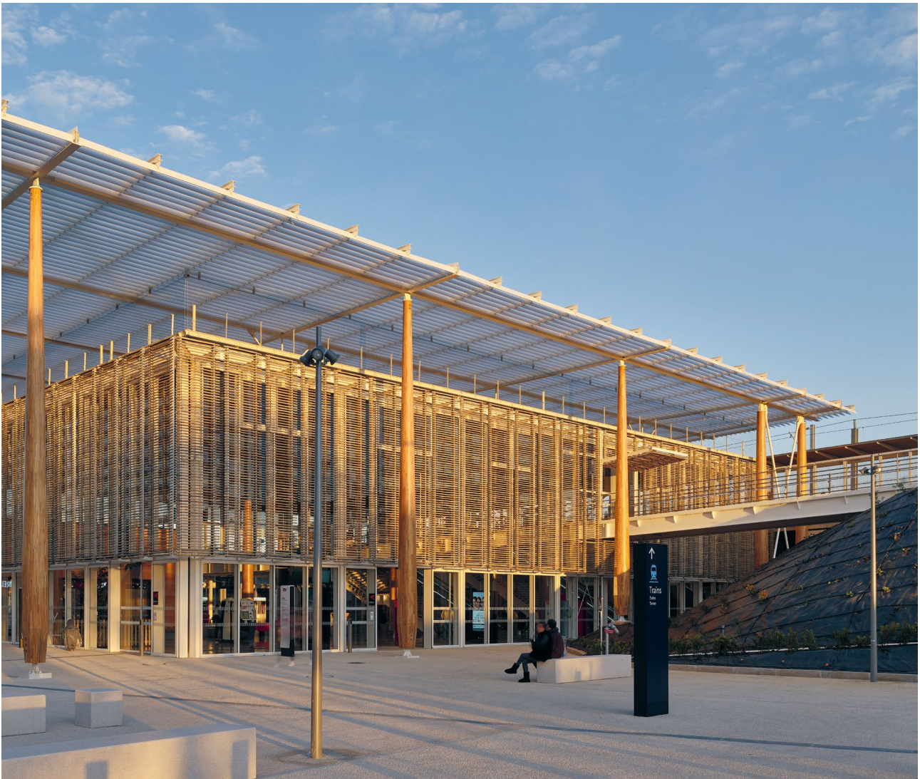
Signalétique voyageurs en gare de Nîmes-Pont du Gard. AREP
