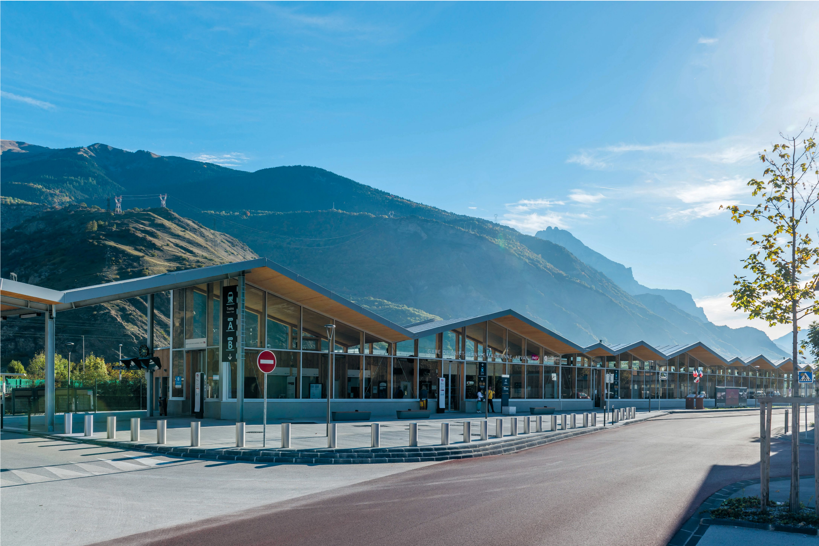
Parvis transitoire de la gare Saint-Jean-de-Maurienne. AREP
