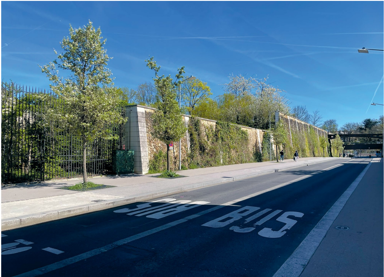
Mur de soutènement végétalisé en gare de Versailles Chantiers. AREP
