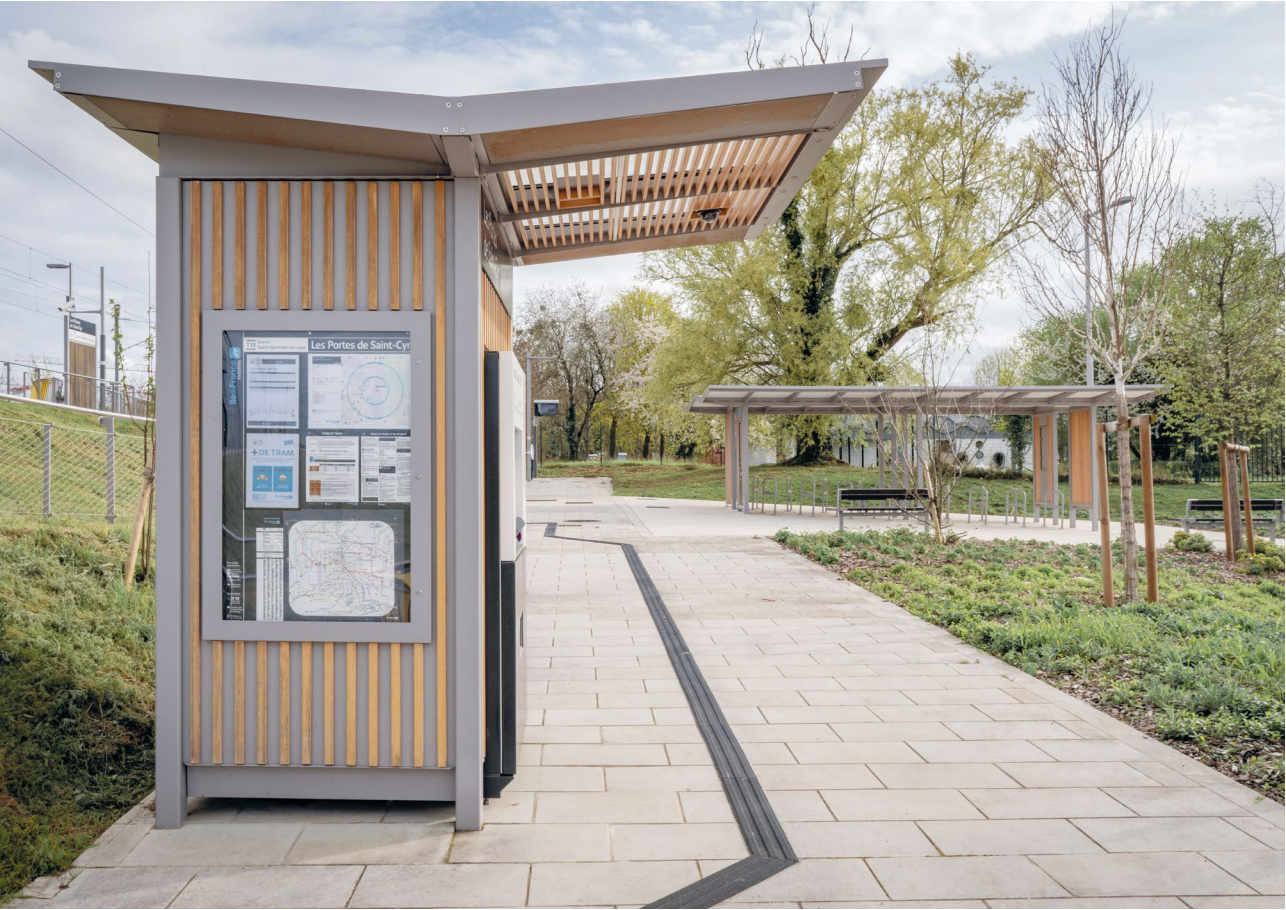
Les nouvelles stations du tram-train T13 – Arrêt Les Portes de Saint-Cyr. AREP
