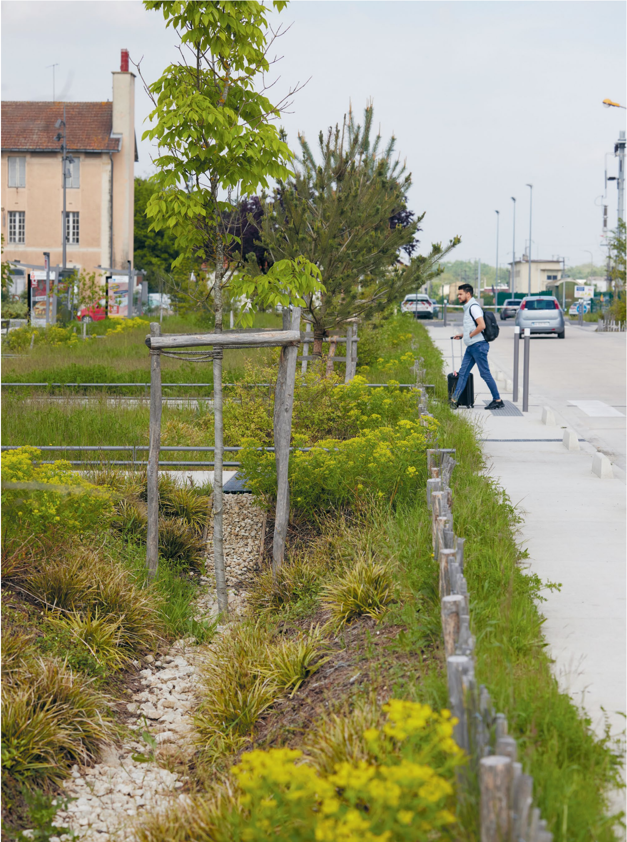
Gestion des eaux pluviales du parvis de la gare de Châlons-en-Champagne via une rivière de graviers en fond de noue. AREP
