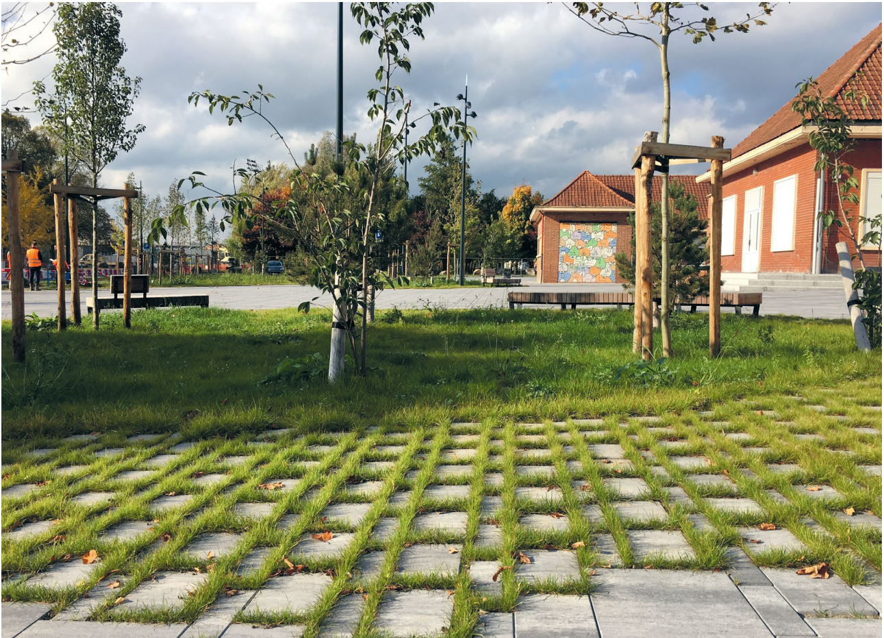
Pavés avec joint engazonnés en gare de Béthune. AREP
