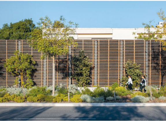
Les massifs ornementaux du parvis de la gare de Cagnes-sur-Mer jouent également un rôle de sécurisation des cheminements piétons.
