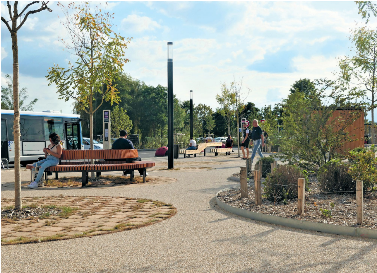
Revêtements perméables et semi-perméables en gare de Bouray. AREP
